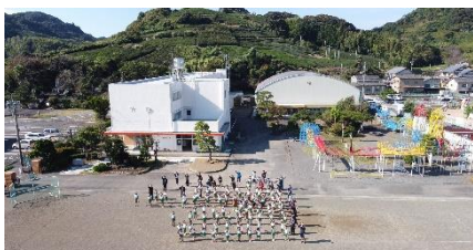
ドローン空撮から
